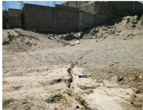
Gambar 3 Kenampakan Likuifaksi Jenis Spreading Lateral Akibat Kejadian Gempa Lombok Utara Tanggal 5 Agustus 2018 di Kecamatan Gangga (Sumber: Tim Pusat Studi Gempa Nasional., 2018)
